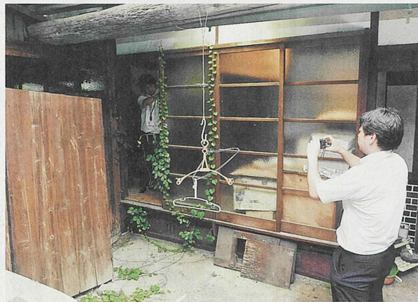
管理を依頼された空き家の状態を確認するダイネンの社員＝姫路市花田町
